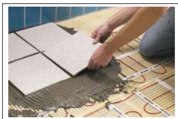
Рис. 3. Монтаж нагревательного мата DTIR-150 в ванной комнате на старую плитку.
